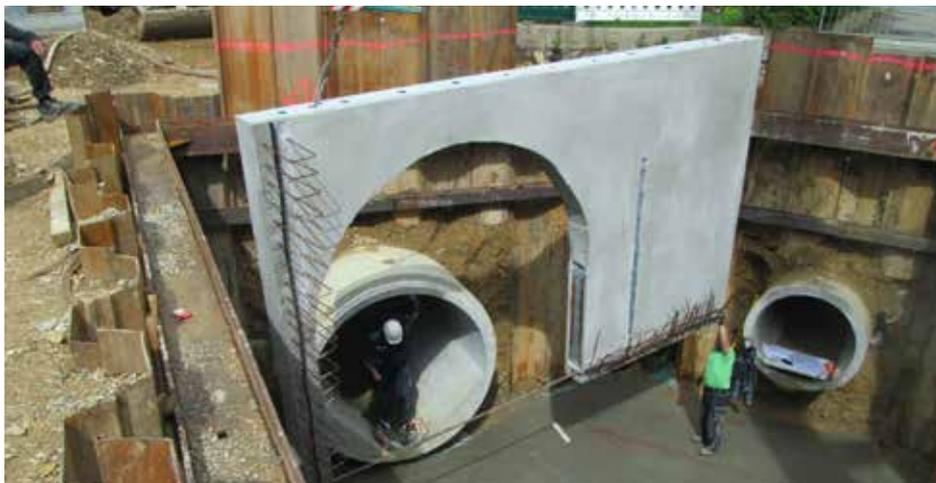
◀ Kanalstauraum. Einbau von Beton-Fertigbauteilen für das Regenüberlaufbecken
