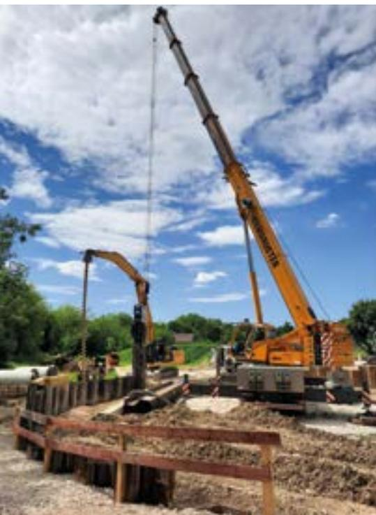
▲ Einbringen eines wasserdichten Spundwandverbaus
