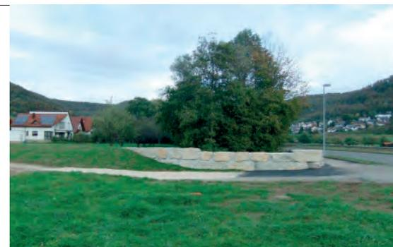
▲ Kombiniertes Mauer- und Dammbauwerk
